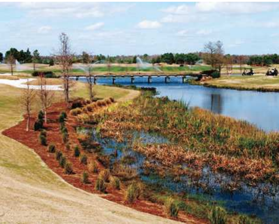
La multiplication des rangs de plantes hors de l'eau et dans l'eau permet de bien filtrer les eaux de ruissellement avant qu'elles n'atteignent le plan d'eau.
